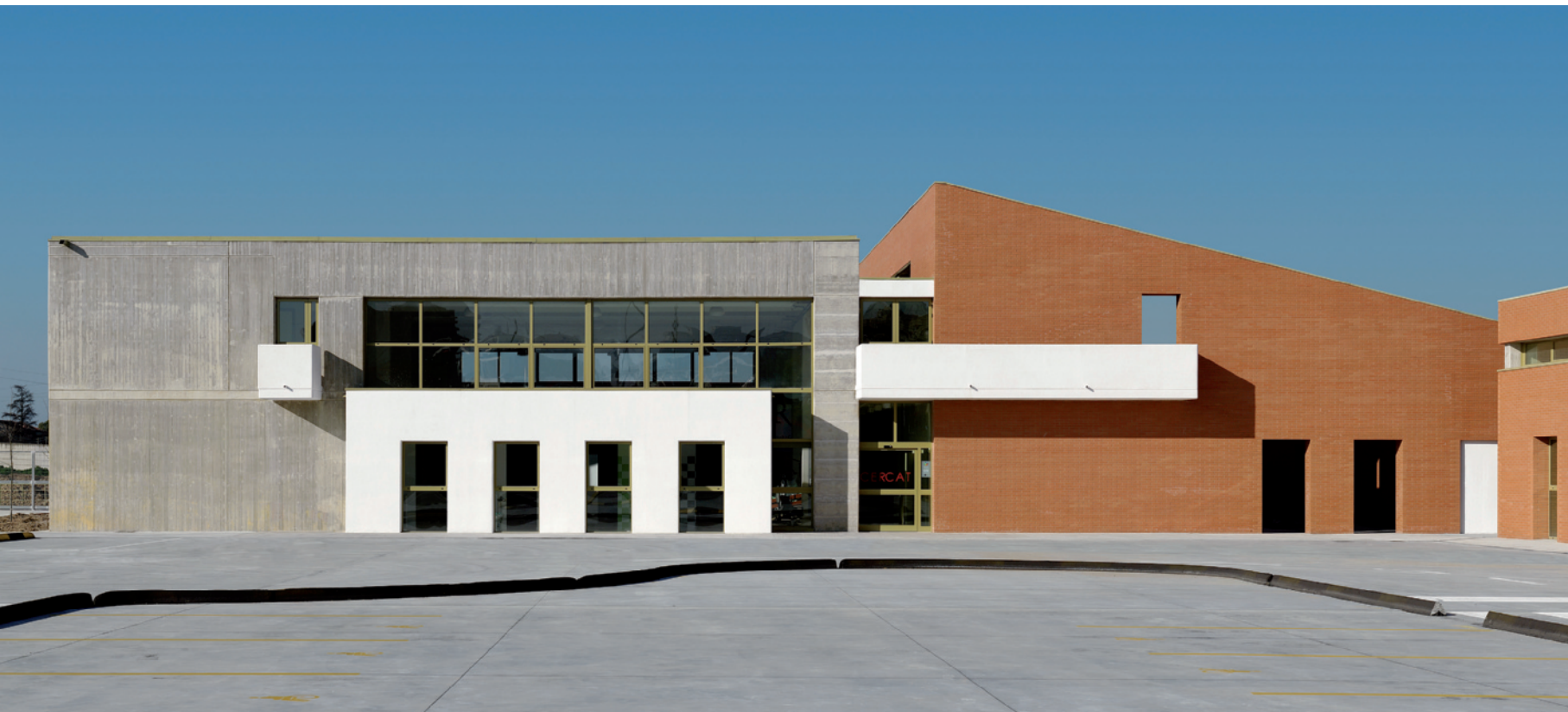
Dall'alto: veduta dalla strada d'accesso; fronte nord-est.
