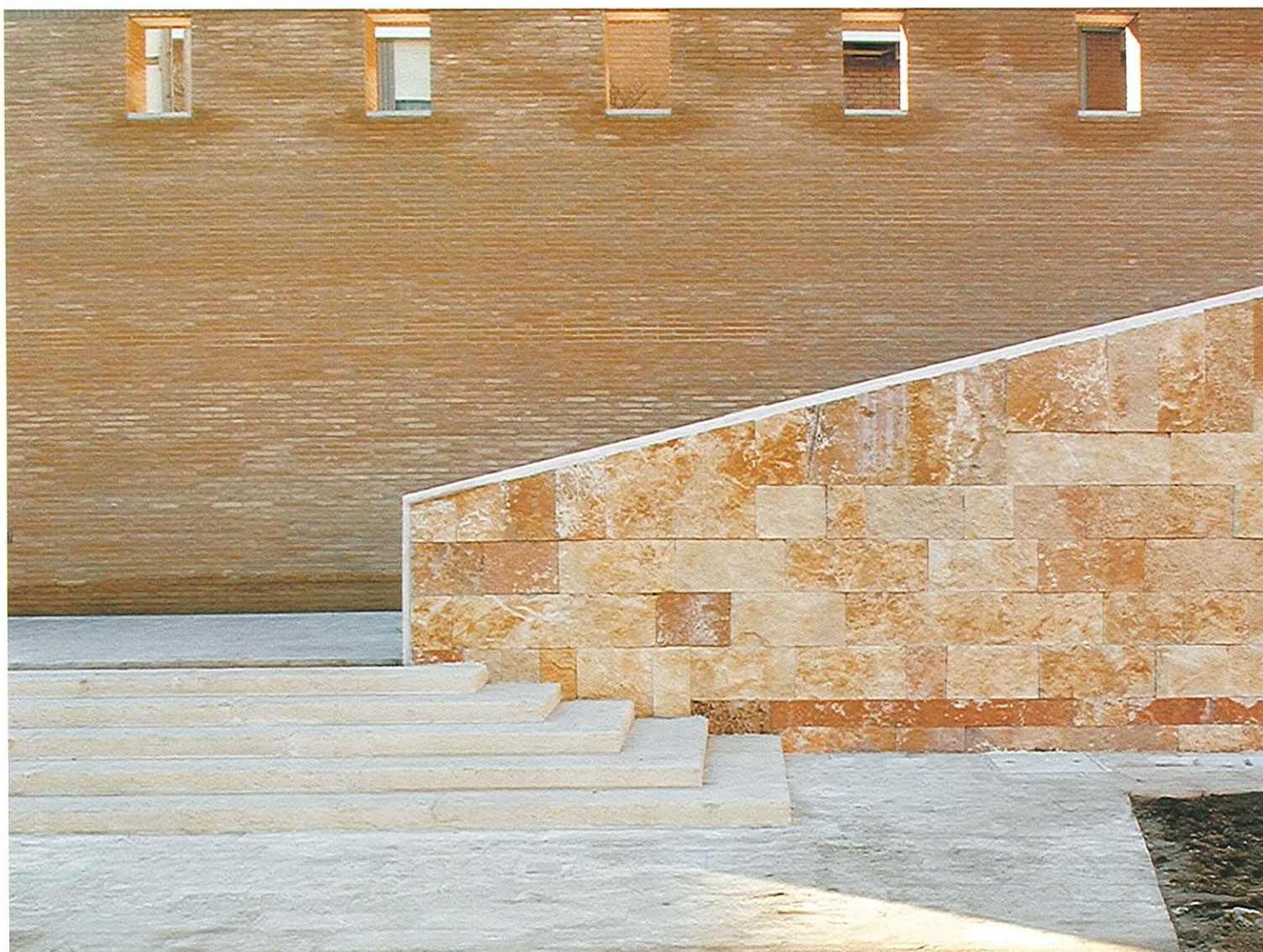
Recupero e completamento del plesso scolastico di Villa Ducale, vista dello scalone di accesso in pietra.
